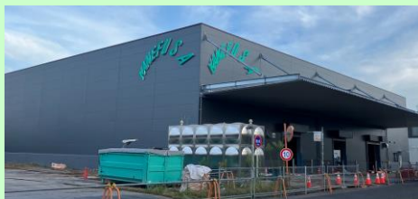
物流センター工事中
