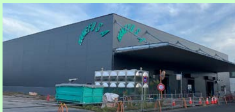
物流センター工事中
